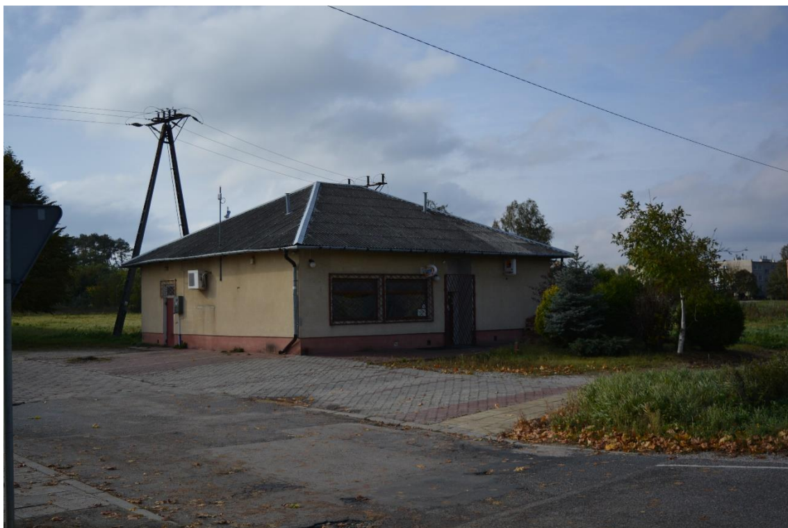
Fotografia 6 Budynek dawnego sklepu w Drwalewie
