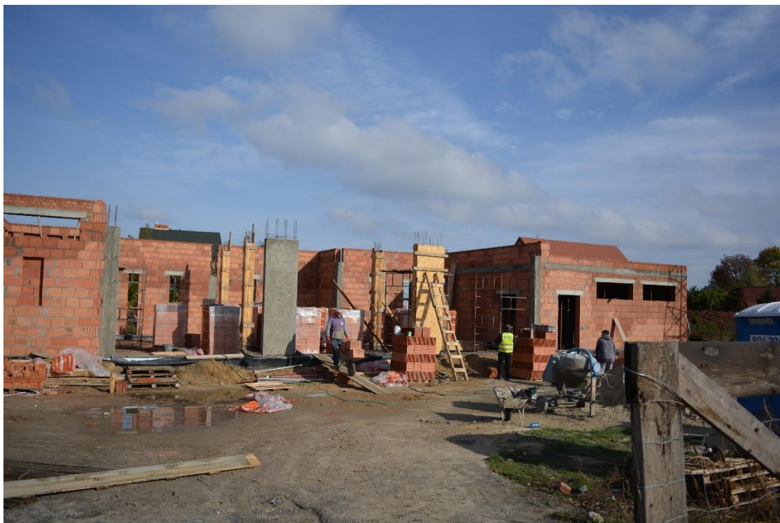
Fotografia 7 Teren budowy Domu Kultury w Drwalewie
